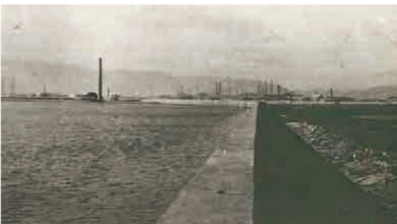
水没した工場(布屋町)『西淀川区制50年の歩み』より
