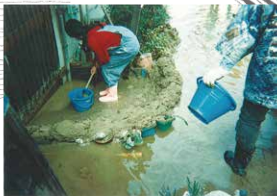
水道管、ガス管、下水道等の損傷は各地で続出しました。写真は、水道水の噴出で水浸しになり、家屋への浸水を食い止めようとしていたところ
