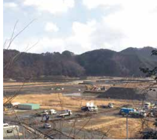
盛土工事が進む釜石市内、向こう側はラグビーW杯2019の会場予定地。
