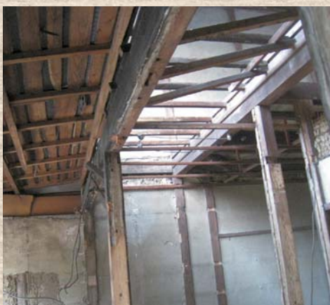
解体中の豊崎長屋
