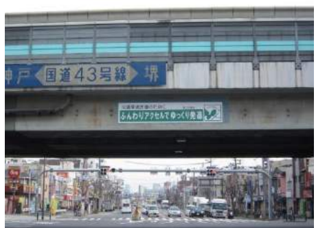
箱桁への設置
