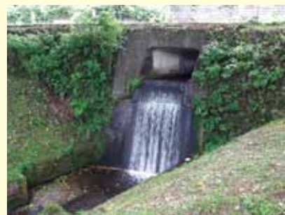
排水沟的情况
