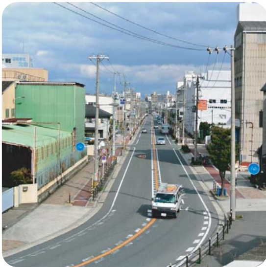
姫福通りもかつて中島水道が通っていた
