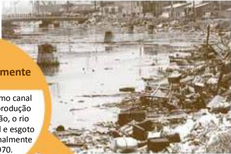
Área da ponte Oshima (antes do aterramento) (Foto: Cidade de Osaka)
