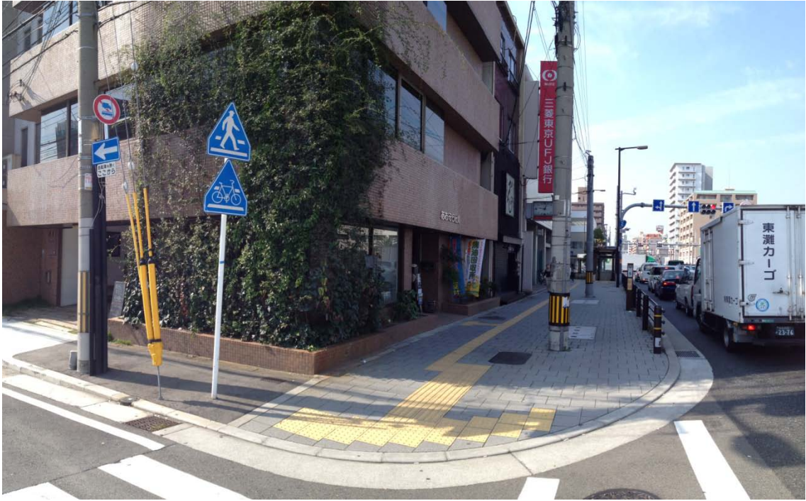
外観北西角より
