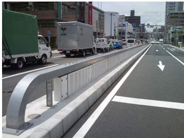
国道2号の低層遮音壁（光触媒塗布タイプ）
