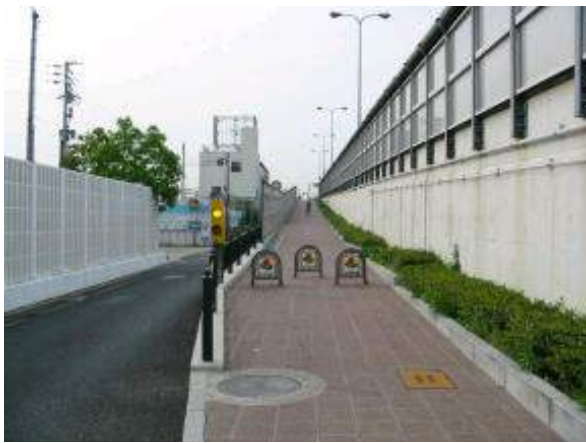
国道43号 出来島自転車歩行車道
