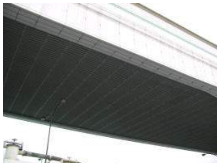
阪神高速 高架裏面吸音板
