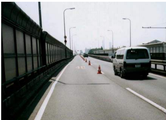
低騒音舗装の敷設の事例（国道43号福町地区付近）
