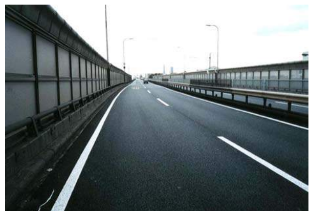
低騒音舗装の敷設の事例（国道43号福町地区付近）
