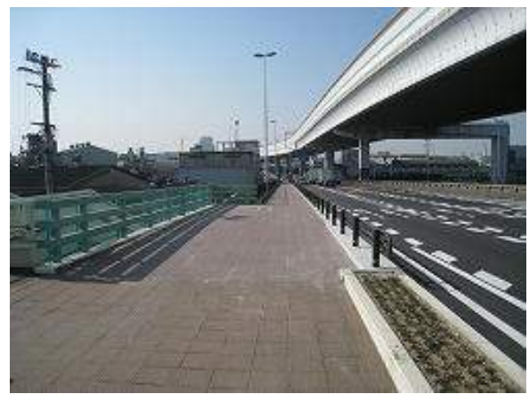
国道43号(下り) 佃地区自転車歩行車道
