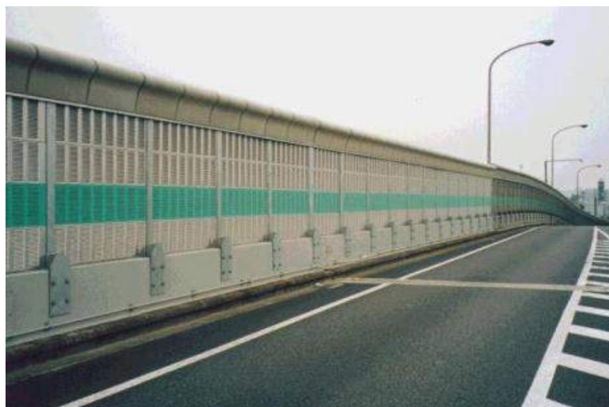
国道43号の新型遮音壁
