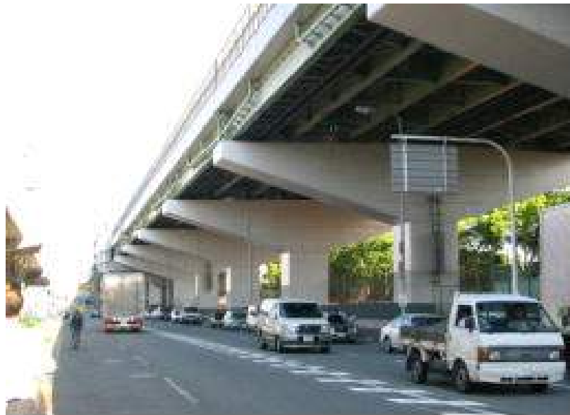
阪神高速 3号神戸線姫島付近
