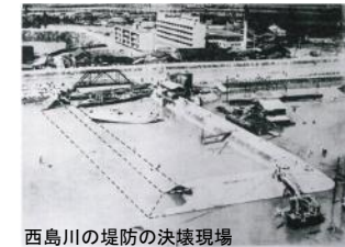
西島川の堤防の決壊現場
