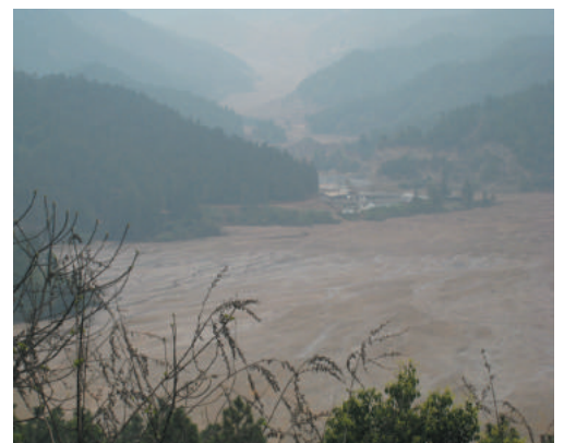
写真2 選鉱くずを含む汚泥が堆積した鉄竜ダム (2008年3月撮影)
