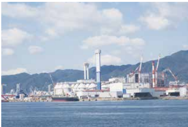
建設が進む神戸製鋼の石炭火力発電所3-4号機(提供:神戸石炭訴訟原告)
