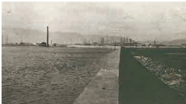
水没した工場(布屋町)『西淀川区制50年の歩み』より
