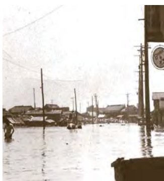
国道2号付近の浸水
