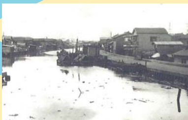
埋め立て前の大野川はとても汚れていました (出典:西淀川今昔写真集—西淀川区制70周年記念—)
