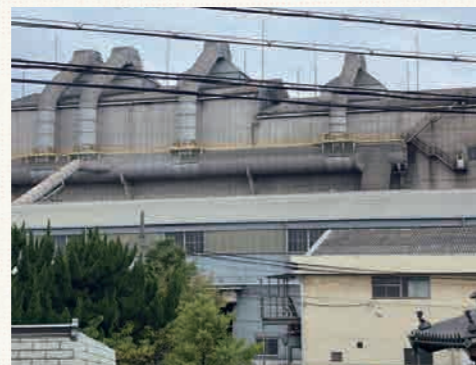
大気汚染物質の排出を抑えるため 建屋集塵装置が設置されています
